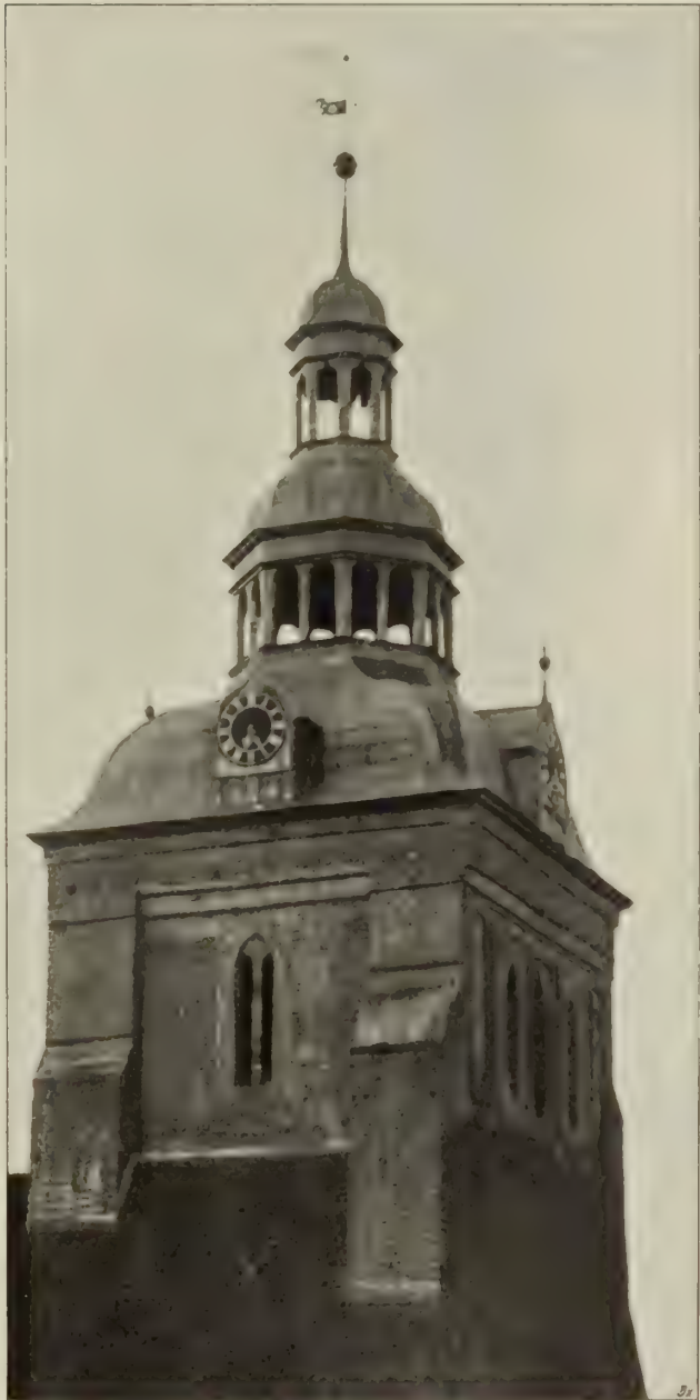
Fig. 295. Wittstock. Turm der Pfarrkirche von Nordwesten.
